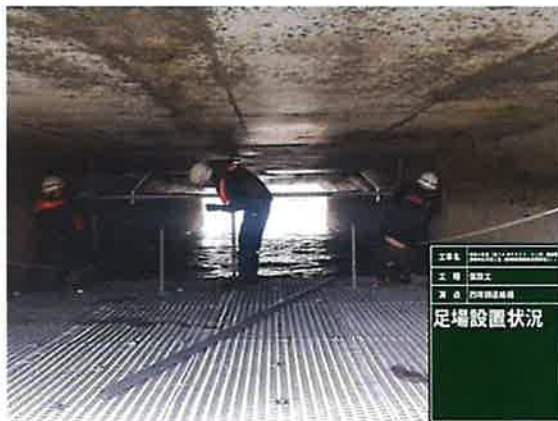
足場設置状況
