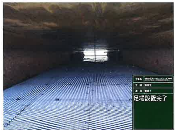
足場設置完了
