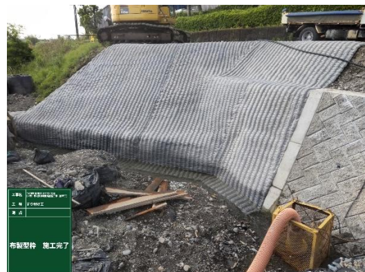
布製型枠施工完了
