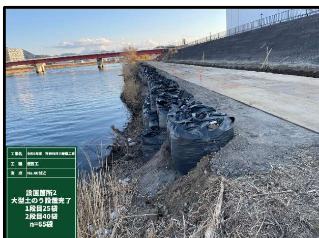
大型土のう設置完了
