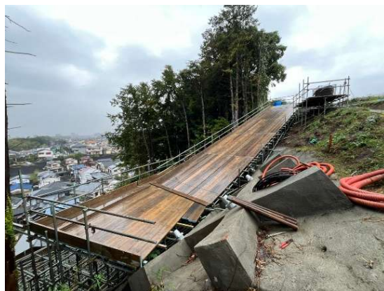
写真-2 削孔機械搬入足場
