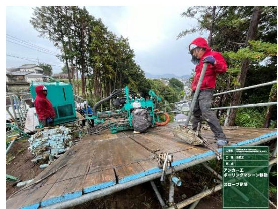
写真-3 削孔機械搬入状況
