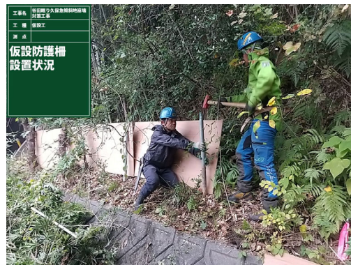
落下物防護柵設置状況
