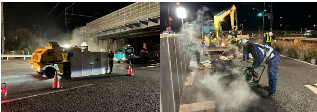
写真-1 小型路面切削機使用及び防音パネル設置状況
