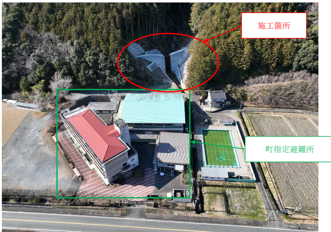
写真 完成写真（町指定避難所と施工箇所との位置関係）
