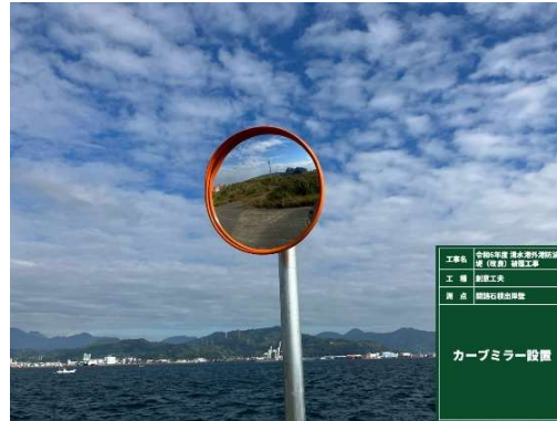
カーブミラー設置
