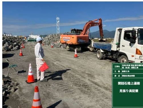
積み込み作業見張り員配置
