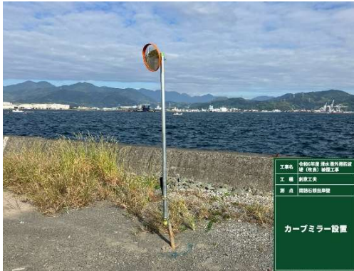
カーブミラー設置
