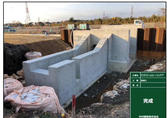
写真-5 樋門完成写真 川裏より望む
