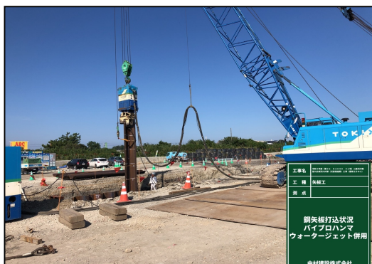
写真-2 鋼矢板打込み状況
