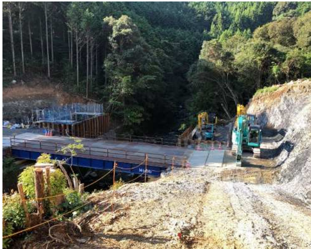
写真-4 橋台工施工状況
