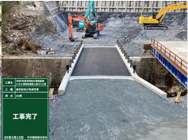
写真-7 橋梁上部工完了
