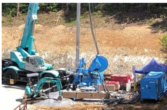
写真-2 矢板打込状況
