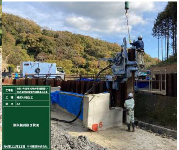
写真-5 矢板引抜状況
