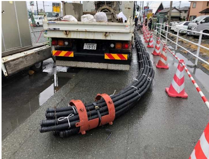
写真-1 FEP 管結束・先頭台車
