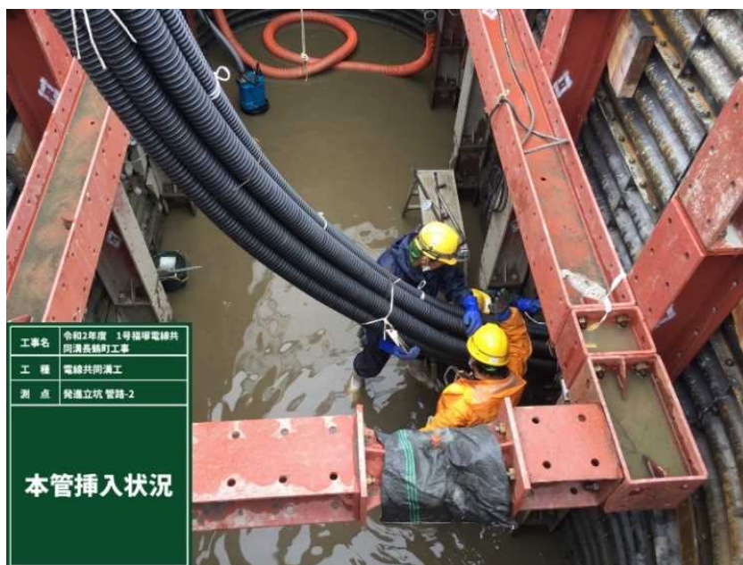
写真-2 発進側挿入状況
