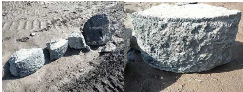
地中障害物(残材)
