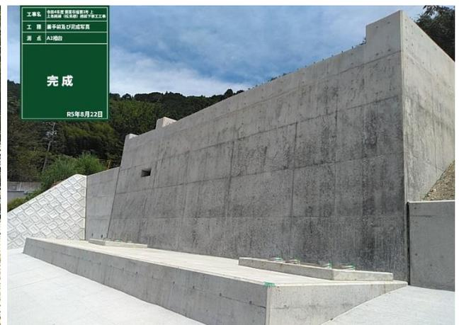
逆T式橋台の施工にあたり、上記対策のほか、逆T式橋台施工前のH形鋼杭建て込みとグラウンドアンカーを利用した仮設土留工の施工、軟岩～中硬岩が分布する地山掘削および残土処分、発破作業による深礎工の施工について、早期着工と工程管理により3月初旬に完了し、コンクリート打設を4月初旬から5月中旬に実施できたことも品質管理にプラスになったと考えられる。
