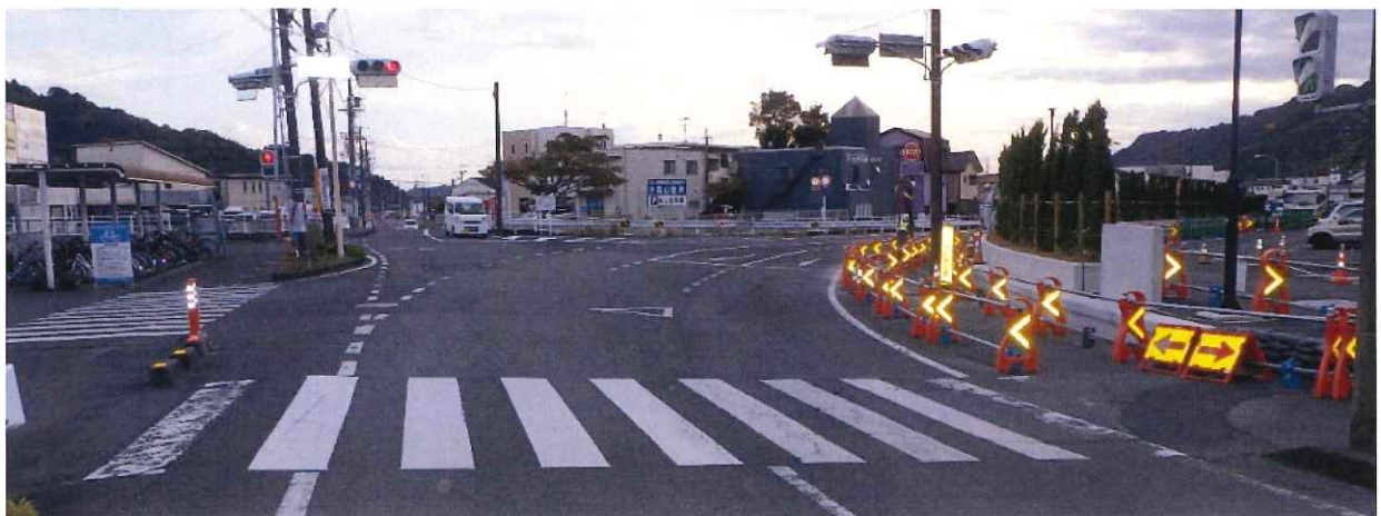
施工状況(変則的な4差路交差点)
