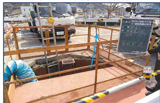
水平ボーリング調査(立坑外)
