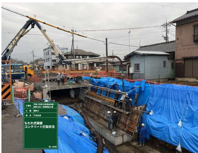
下段コンクリート打設状況
