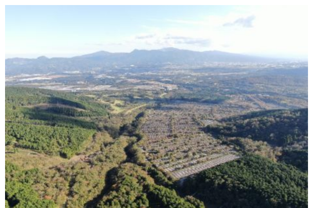
現場下流部保安物件 (富士霊園、富士スピードウェイ、住宅地)
