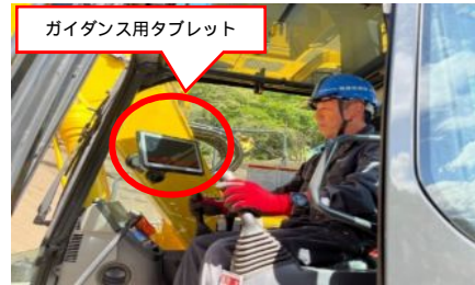
マシンガイダンス施工状況
