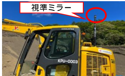
マシンガイダンス施工状況
