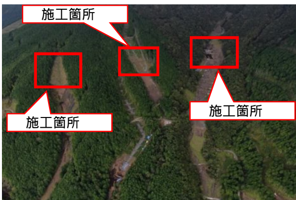
角取山地区崩壊地 全景
