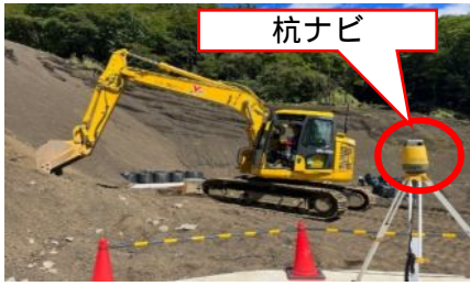
マシンガイダンス施工状況
