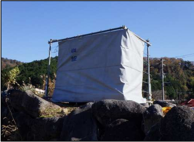
写真-1 防音シートの設置
