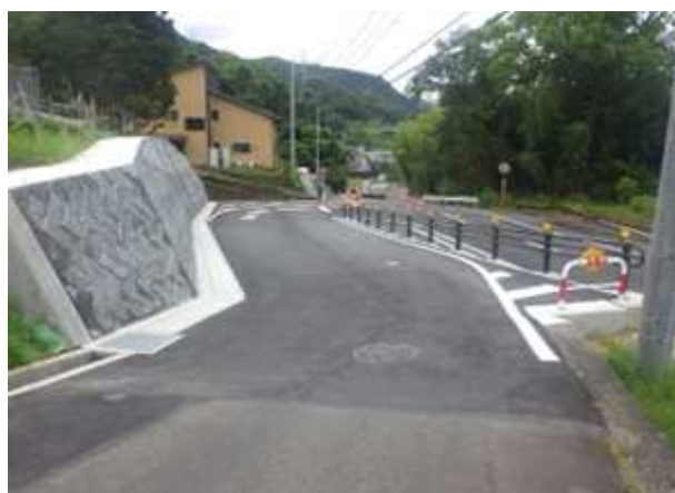
取付道路 完成
