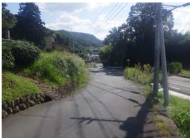
取付道路 着手前
