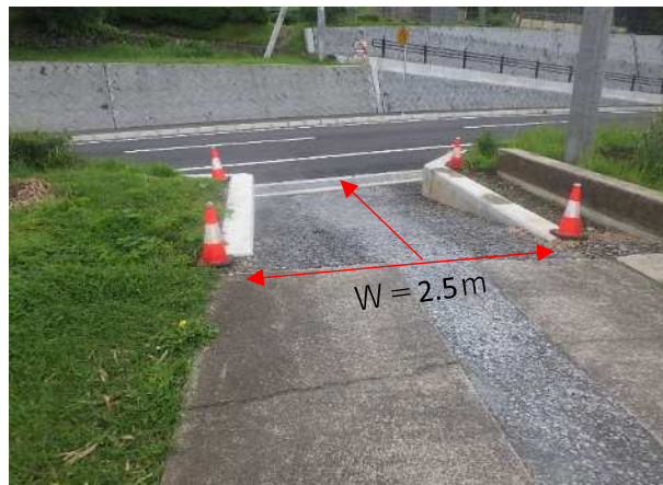
乗入施工状況
