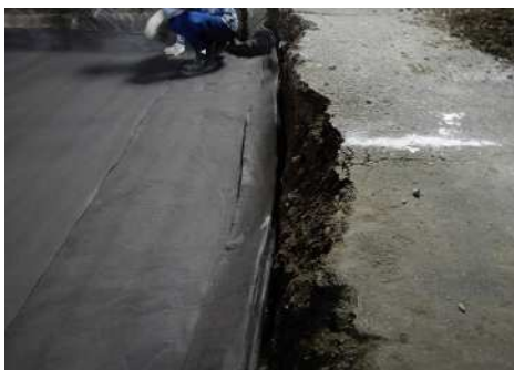
ガスバーナーによる熱溶着
