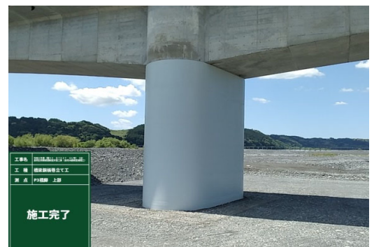
橋脚上部施工完了
