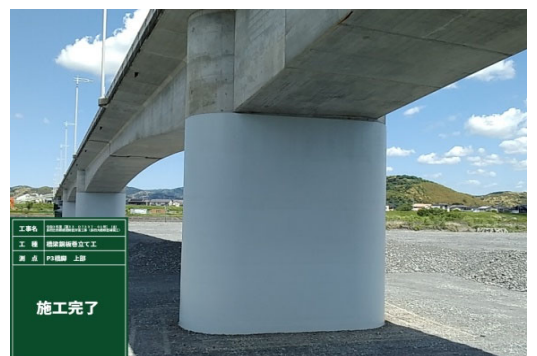
鋼板防錆完了
