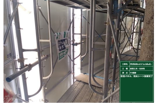
足場内部 (橋脚下部)
