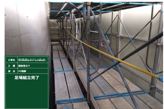
足場内部 (橋脚上部)
