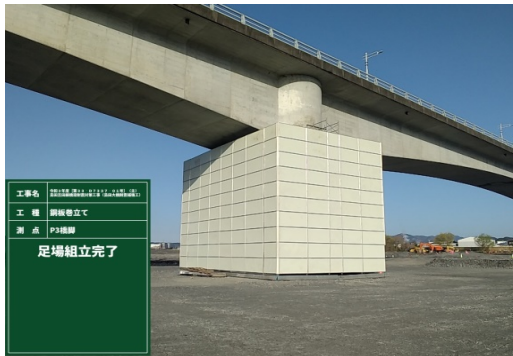
足場設置完了 (橋脚上部)
