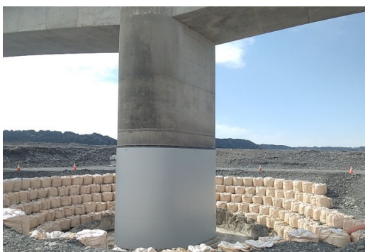
橋脚下部施工完了
