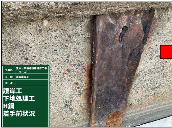
(写真 3-2 下地処理前)
