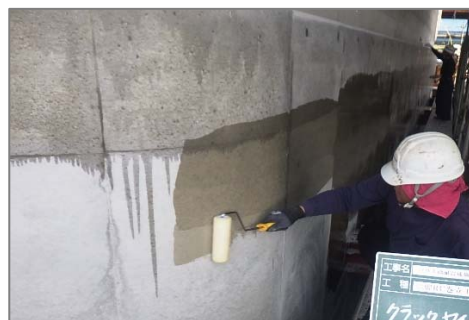
クラックセイバー塗布状況
