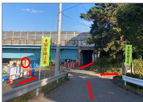
現場前の道路状況
