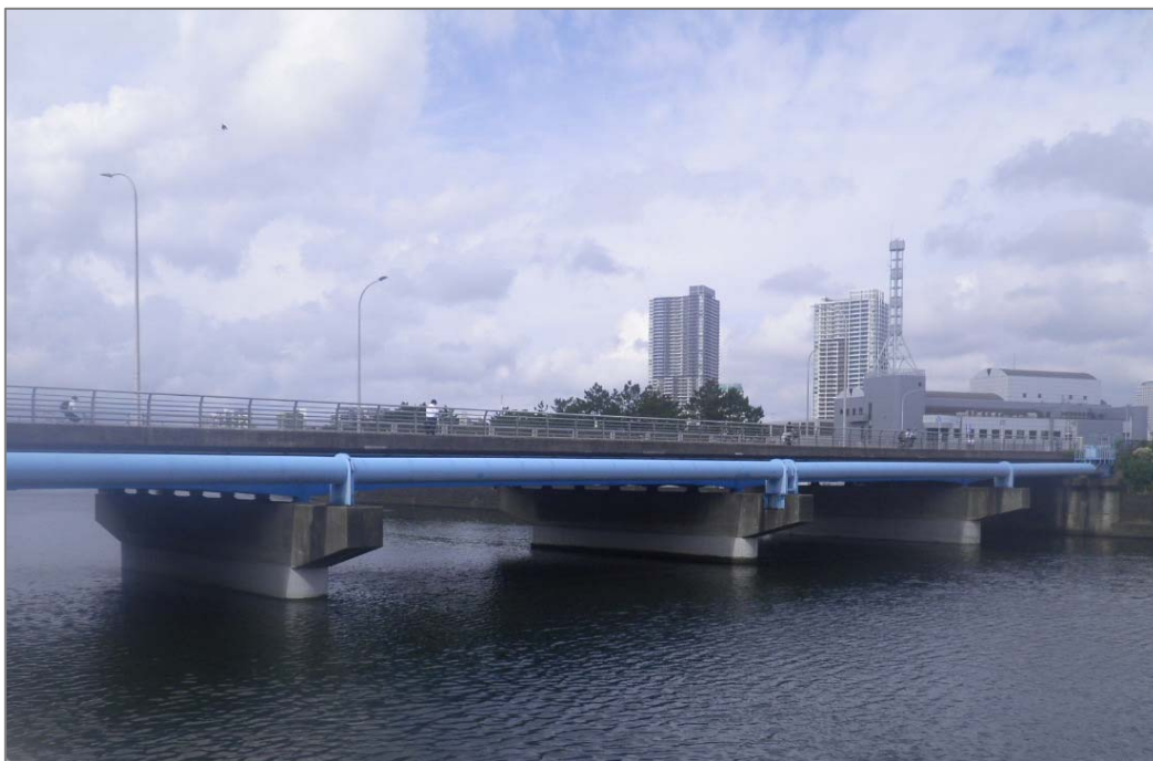
完成写真（手前から P1 橋脚）
