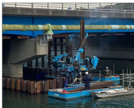
クリアパイラー 2台使用
