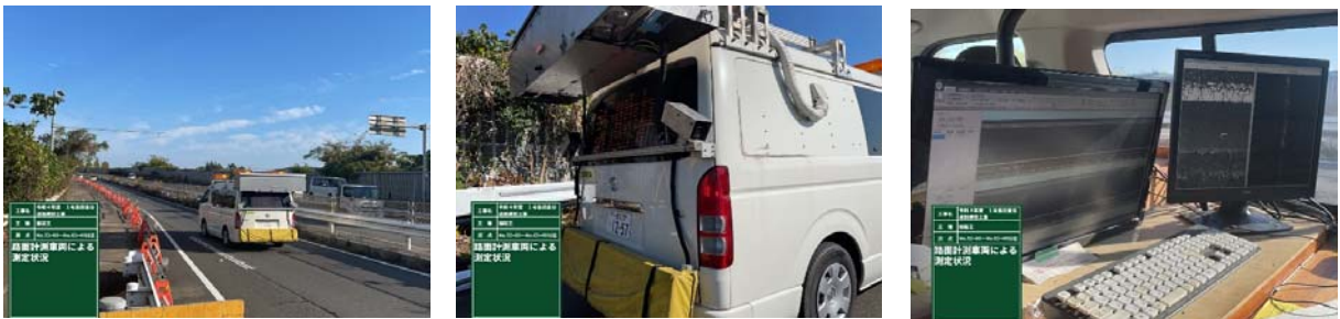
番生寺地区 路面性状測定車による測定状況
