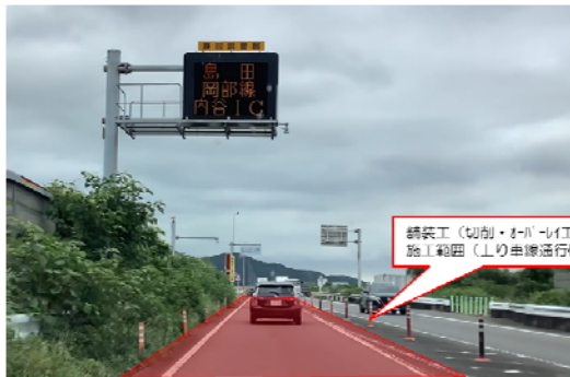
番生寺地区 施工前現況写真
