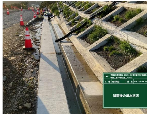
湧水状況(終点側)
