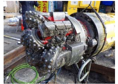
先導体引抜後
