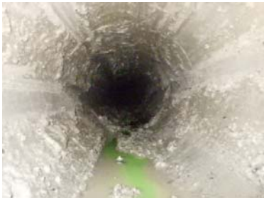
孔壁内部（崩れ無し）
