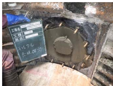
孔壁内をモルタル充填
