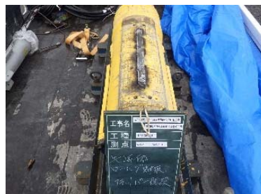
推進機の補強
