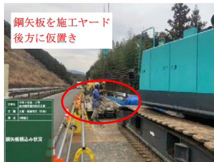
鋼矢板仮置き場（施工ヤード後方）
