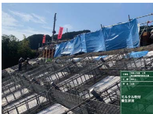
ブルーシート養生
