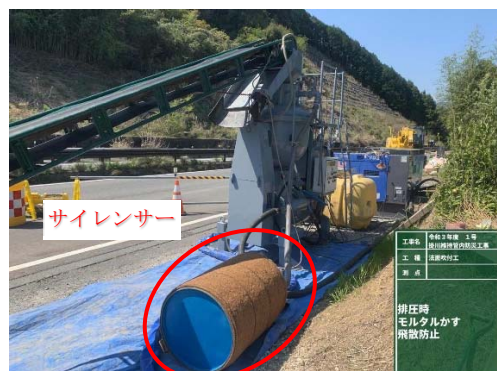
サイレンサーを介し残圧を抜く
