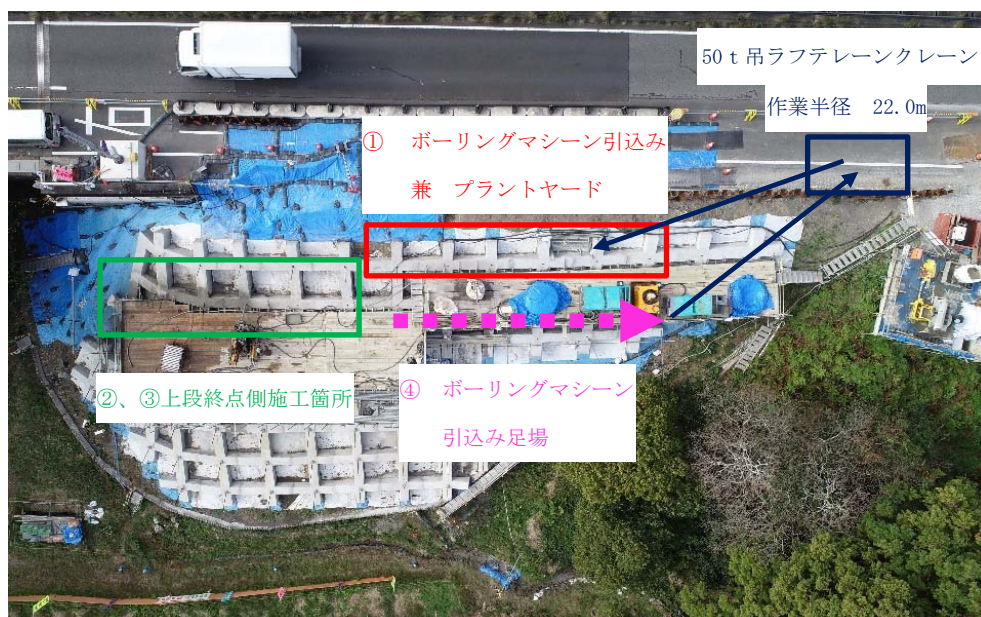
上段終点側施工時
