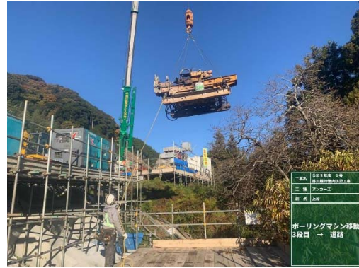
④ 3段目引込み足場から本線へ楊重
