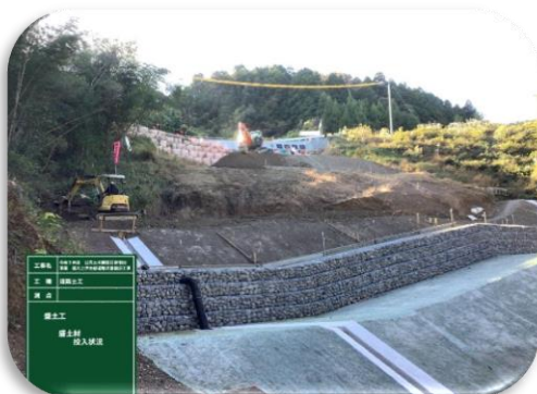
土砂搬入状況
