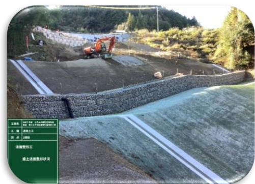
盛土整形状況
