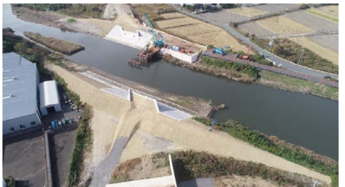
A2橋台側からA1橋台側を望む
