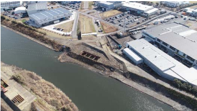
A1橋台側からA2橋台側を望む
