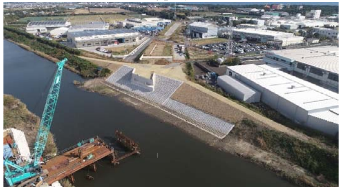
A1橋台側からA2橋台側を望む
