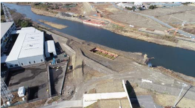
A2橋台側からA1橋台側を望む
