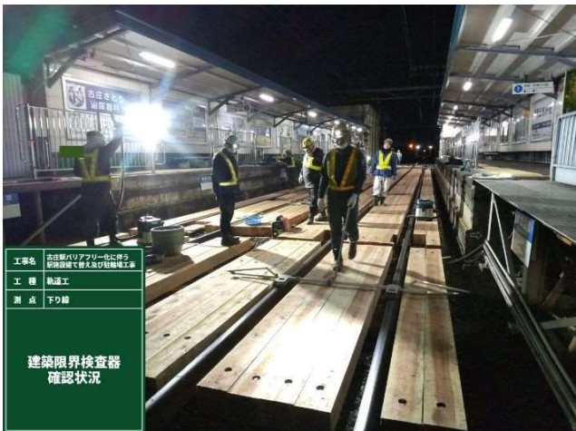
建築限界確認状況 (写真-3)
