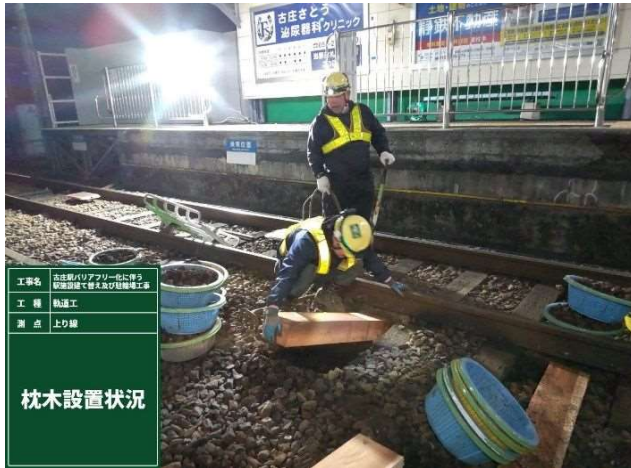
マクラ木設置状況 (写真-1)
