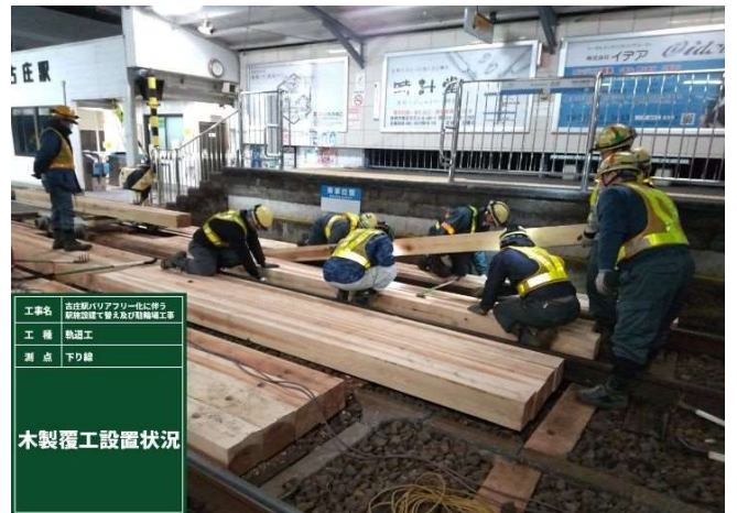
木製覆工設置状況 (写真-2)
