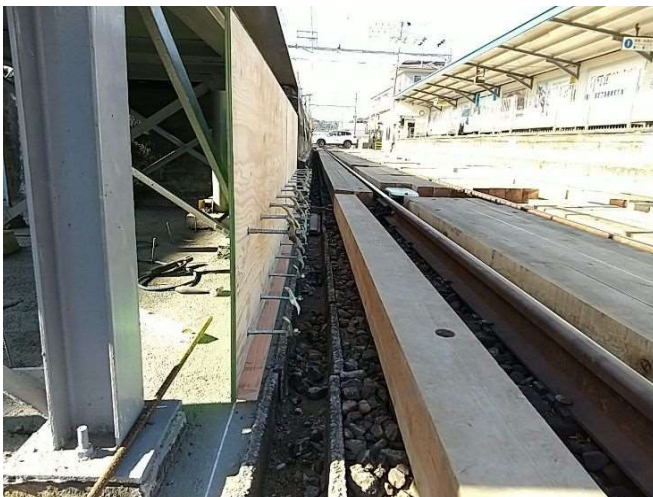
型枠設置状況 (写真-9)
