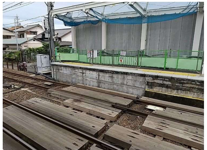
ホーム延伸完了 (写真-8)
