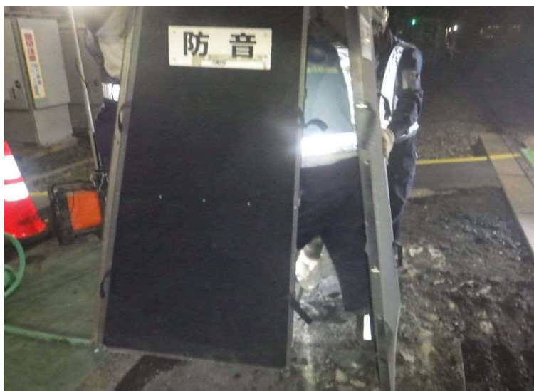
(写真-8 、ブレーカー使用による舗装版撤去)
