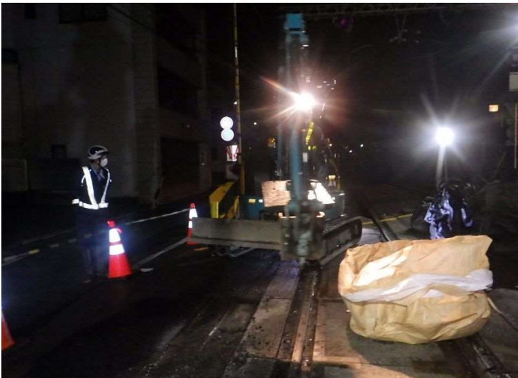
(写真-3 掘削状況)
