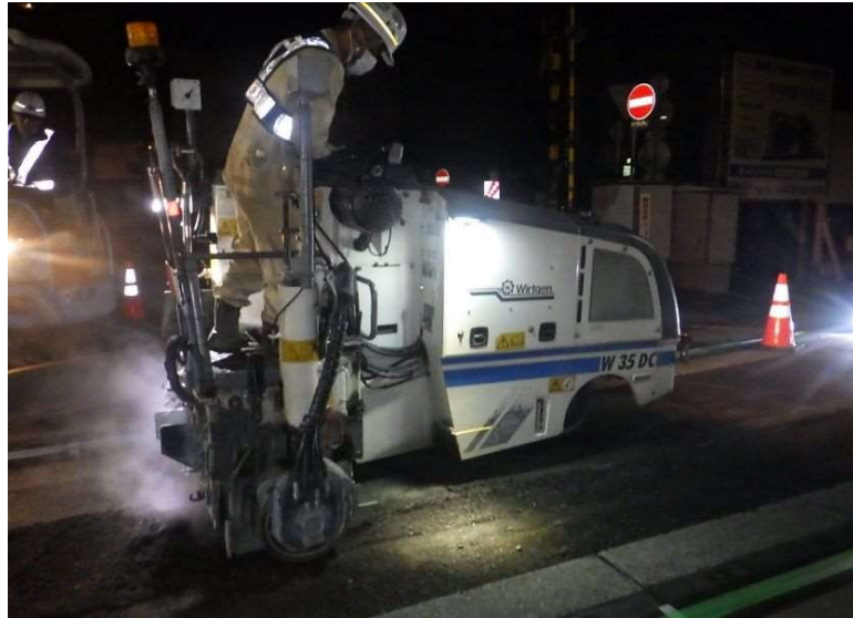
(写真-9 、小型切削機による舗装版撤去)
