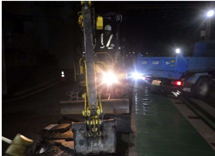
(写真-7 、バックホウによる舗装版撤去)
