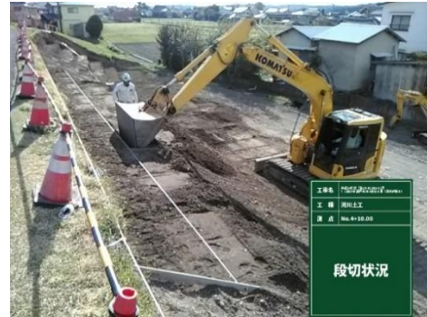
段切り 2 段目以降（下部からの施工）
