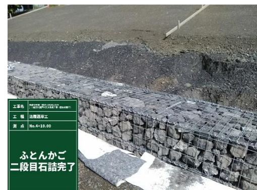
ふとんかご施工完了 (ハイパーマット多段型使用)
