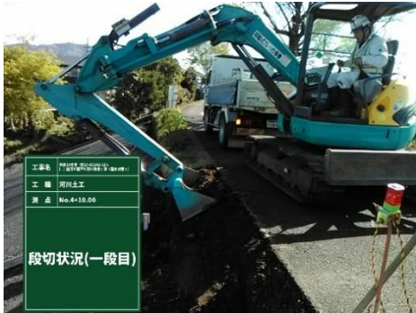
段切り 1 段目（上部からの施工）
