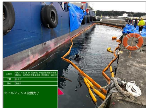
—オイルフェンス設置完了写真—
