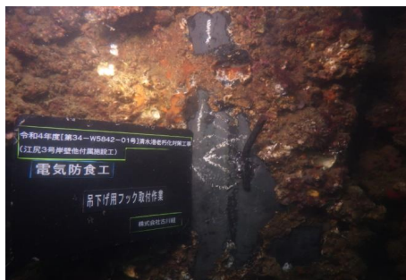
取付フック設置
