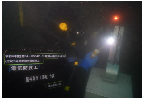
陽極溶接取付
