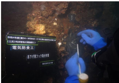
取付フック設置
