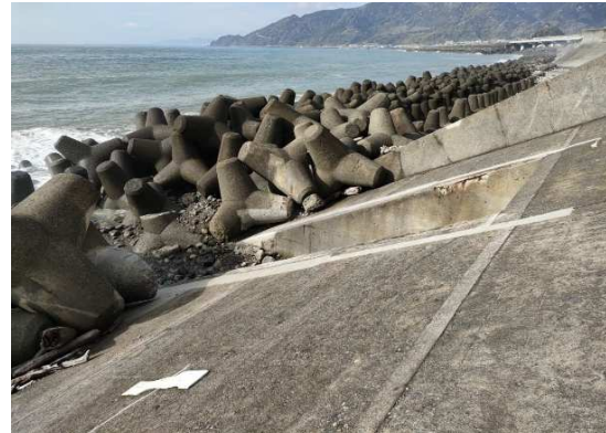
八木沢樋管 完成
