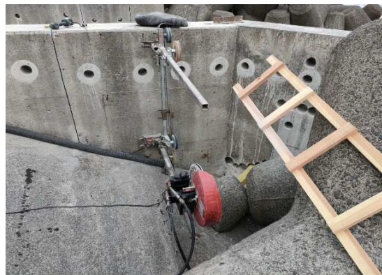
②コンクリート先行切断状況
