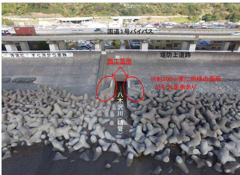
図2 構造物撤去箇所 上空写真
