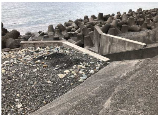
堰沢樋管 着手前
