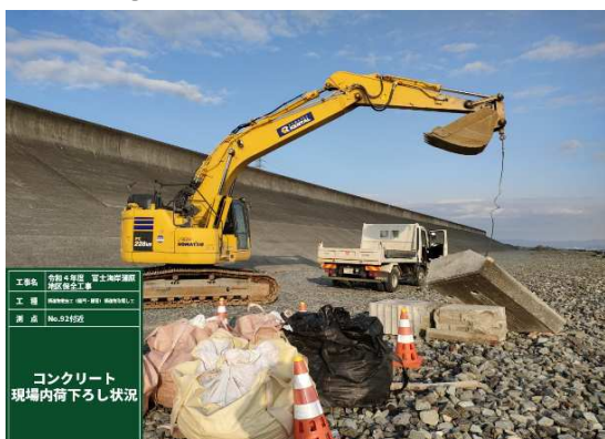
⑤コンクリート塊荷卸し状況
