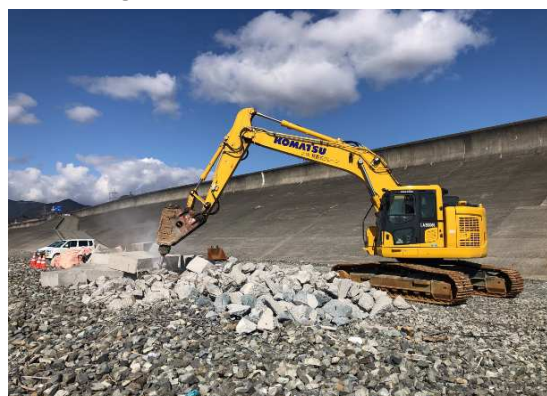
⑥コンクリート塊小割状況
