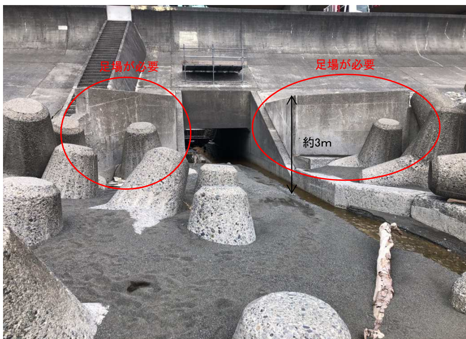
図3 構造物撤去箇所 海側からの写真
