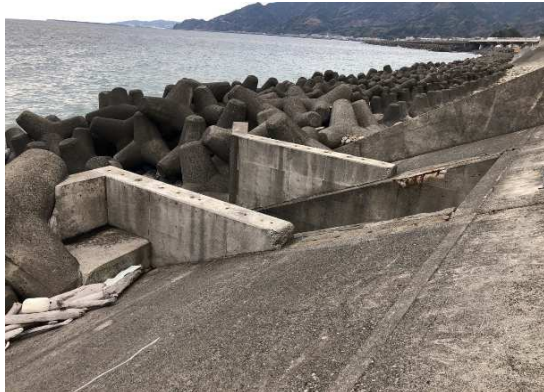
八木沢樋管 着手前
