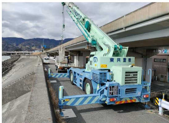
④コンクリート塊積込状況
