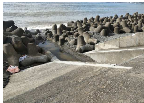
堰沢樋管 完成
