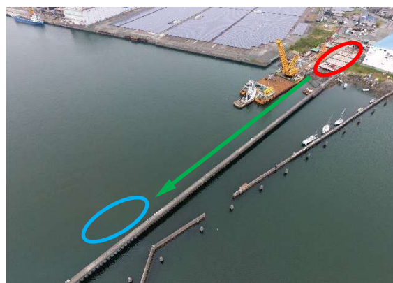
施工箇所詳細(清水区折戸)
