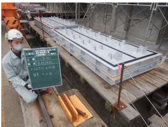
止水板仮置き状況
