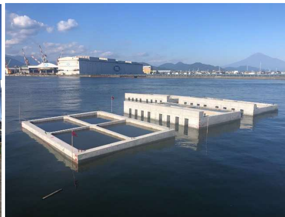
ケーソン仮置き完了
