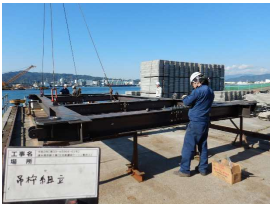
吊り具製作状況
