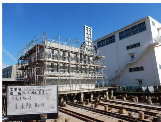
止水板取付け状況
