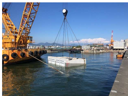
ケーソン進水補助吊り状況
