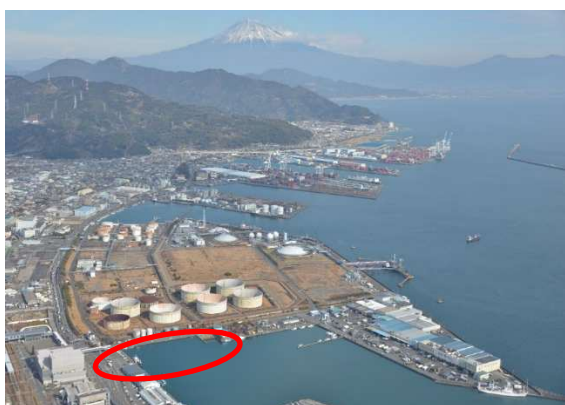
ケーソン据付予定箇所(江尻岸壁)
