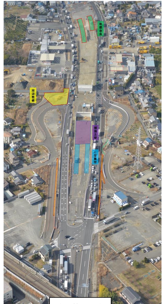
施工箇所写真
