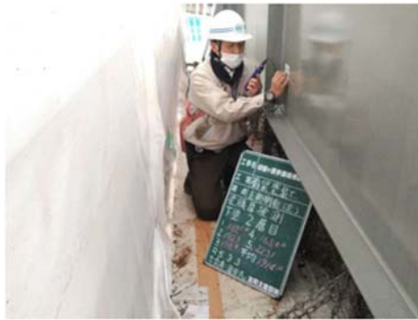
下塗り2回目塗膜厚検測
