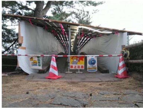
吊り足場及び屋根設置（創意工夫）
