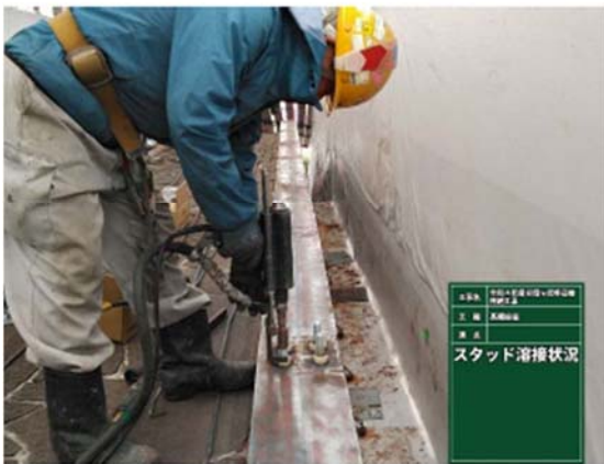
スタッドボルト溶接
