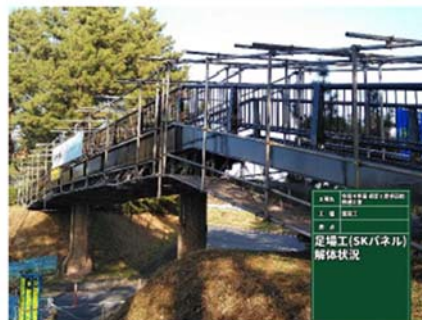
足場（SKパネル）解体時、片側交互通行
