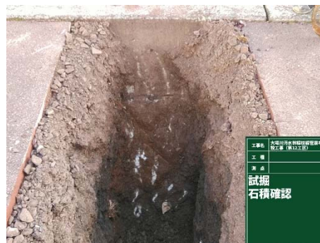
図-2 既設構造物確認
