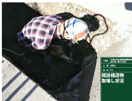
図-3 既設構造物取壊し状況
