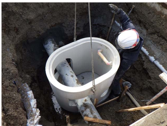
図-4 マンホール設置状況
