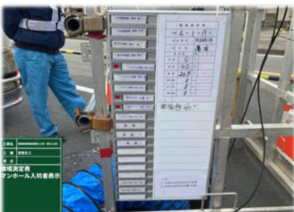
マンホール入坑表示
