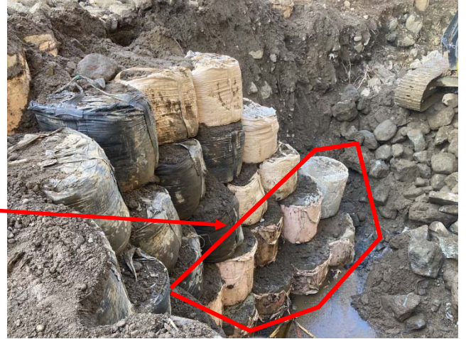
資料-6 下段はコンクリート土のうを設置
