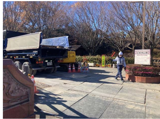
写真-4 交通誘導状況
