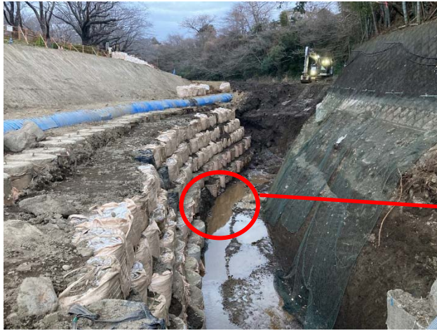
写真-5 大型土のうによる土留め設置
