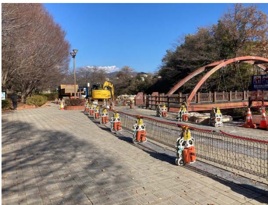
写真-3 侵入防止柵設置
