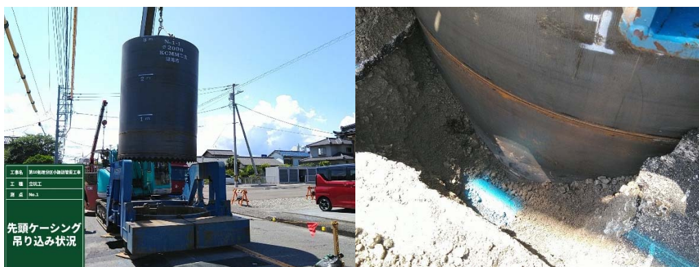
掘削機ケーシングと水道管の位置
