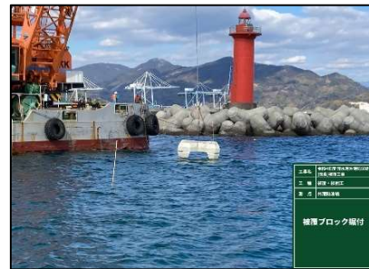
ブロック据付状況
