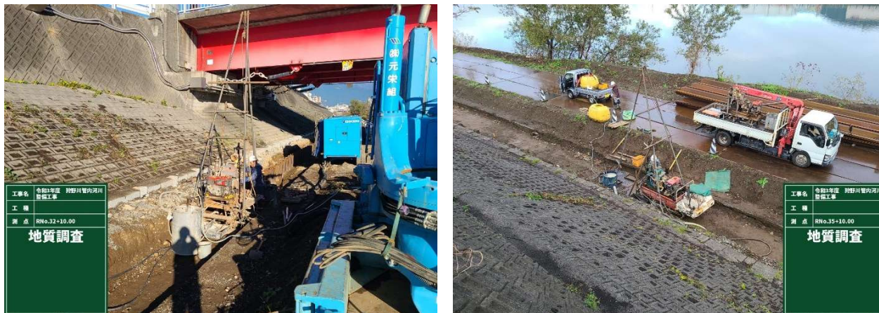
写真-2 ボーリング調査実施状況
