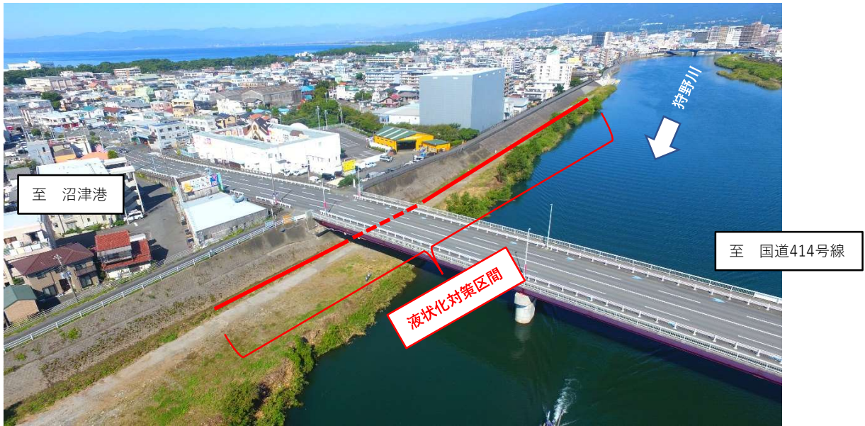
写真-1 工事着工前
