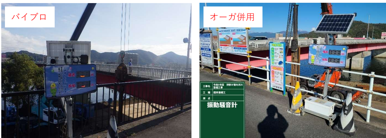
写真-3 「振動騒音計」の設置
