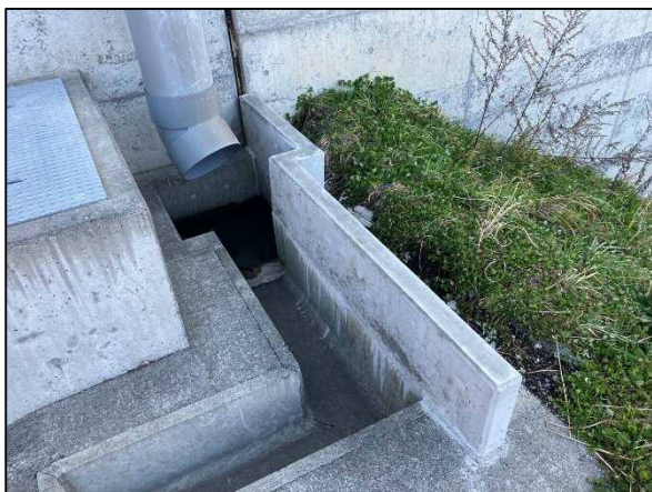
生コン打設によるコンクリート壁
