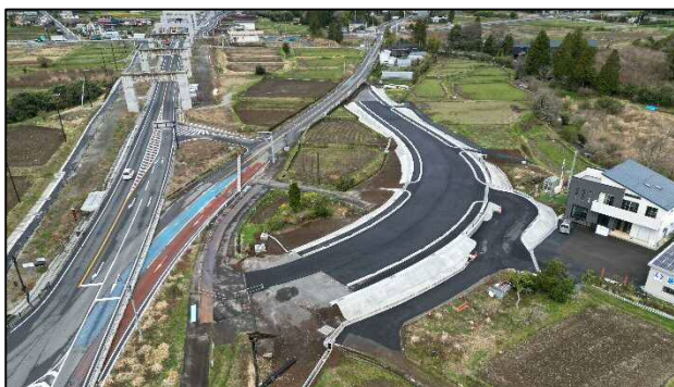
完了時全景写真
