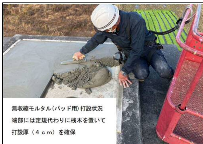
無収縮モルタル打設状況
