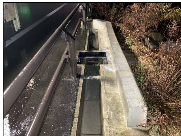
歩車道境界ブロックによるコンクリート壁
