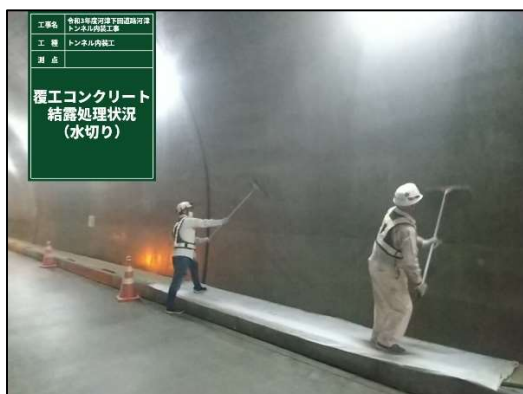
写真-5 試験施工(覆工コンクリート水切り)
