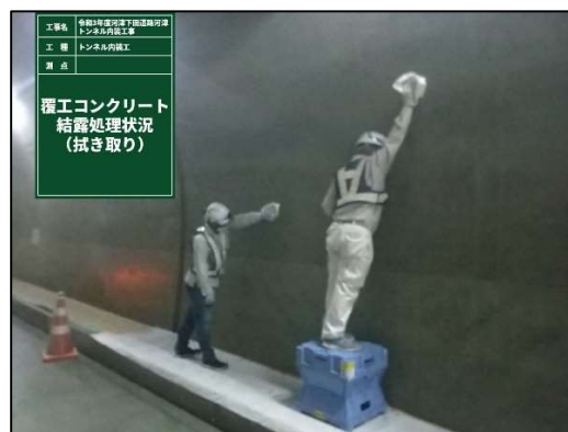
写真-6 試験施工(拭き取り)
