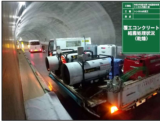
写真-7 試験施工(乾燥)
