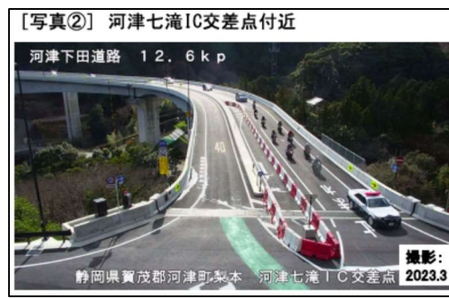
写真-2 河津七滝 IC 交差点付近
