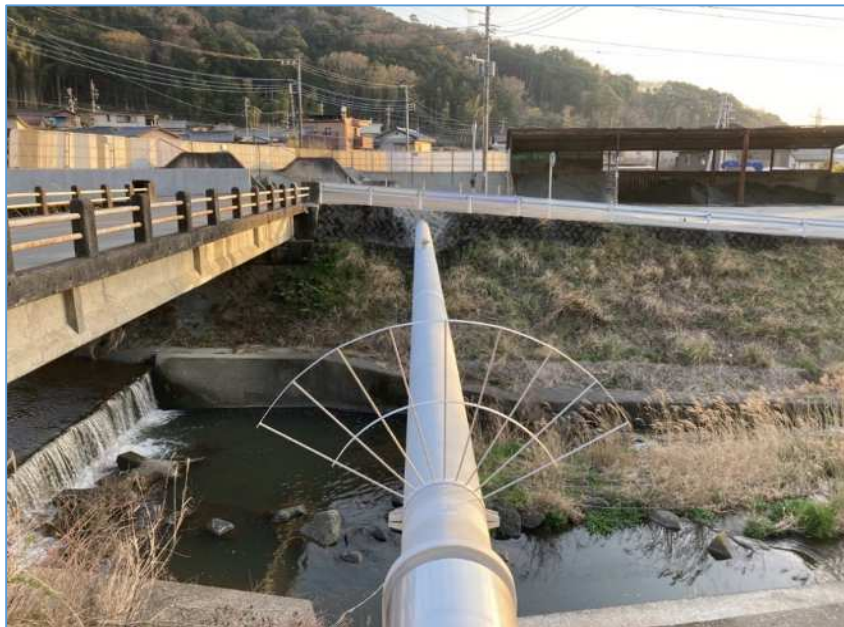
完成写真(右岸側より)
