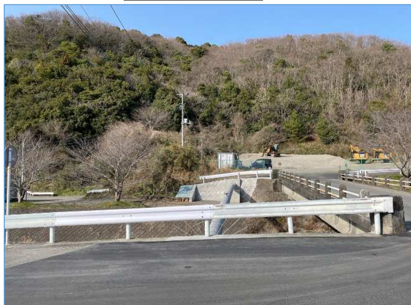
完成写真(左岸側より)
