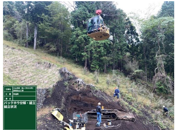
ケーブルクレーンによる重機の搬入状況
