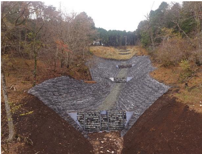
奥の沢16工区完成写真
