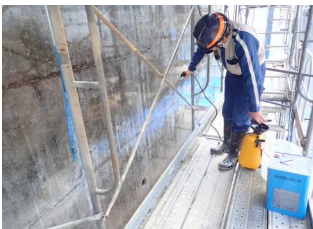
コンクリックエース (コンクリート表面養生剤散布)
