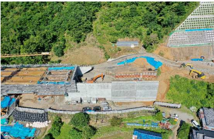
L型擁壁 完了
