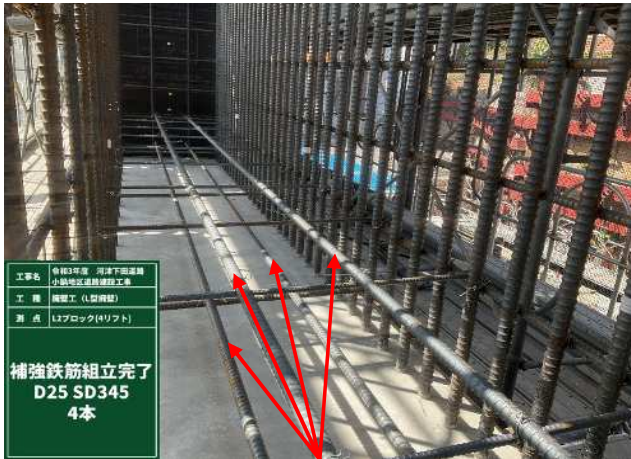
補強筋設置完了
