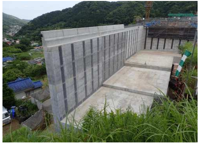
L型擁壁 完了
