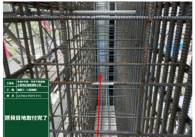
誘発目地設置完了
