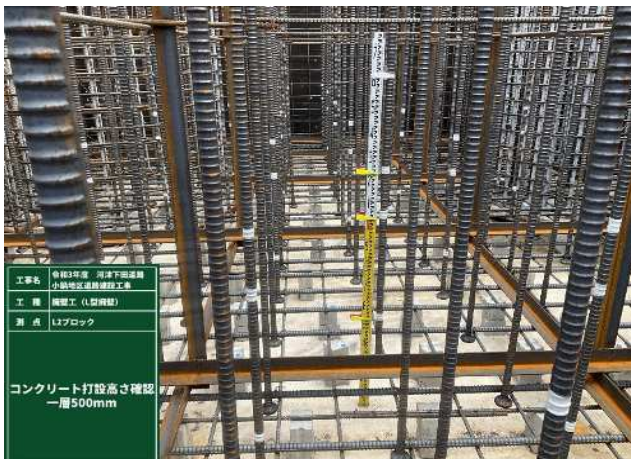
型枠内鉄筋 50cmマーキング
