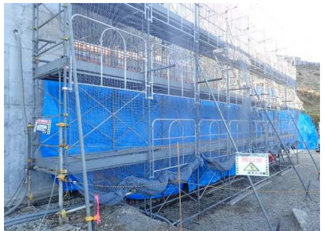
ブルーシート養生
