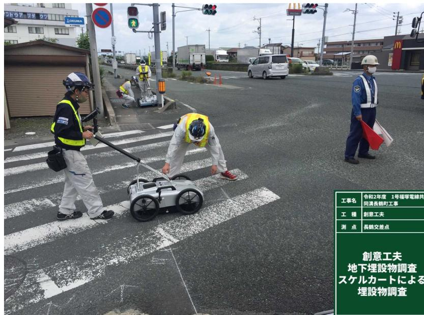
写真-4 多配列地中レーダによる地中探査
