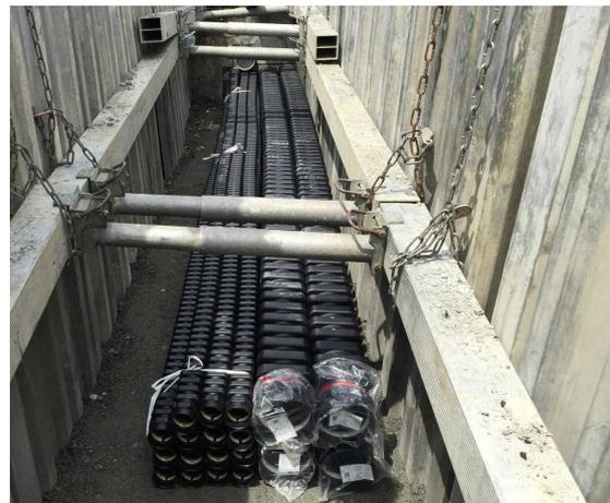
写真-2 管路（結束型多条管）
