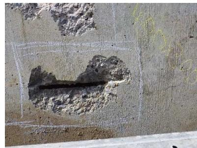
写真-2 コンクリートの浮き・剥離・剥落
